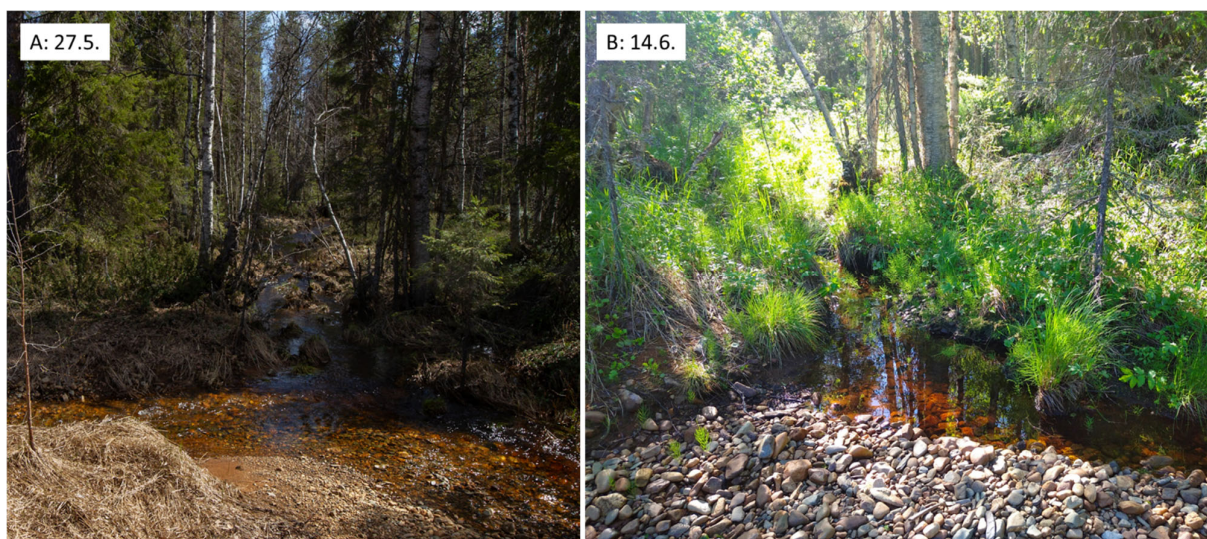
Kuva 3-10. Vanhan ja uuden uoman liittymäkohta tieltä katsottuna 27.5. (A) ja 14.6.2021 (B). Uusi uoma, joka kesäkuussa oli jo täysin kuiva, virtaa vasemmalta, ja vanha uoma tulee suoraan kohti kuvaajaa. Uomien kulku ja kuvaussuunnat on esitetty kuvassa 3-8.
