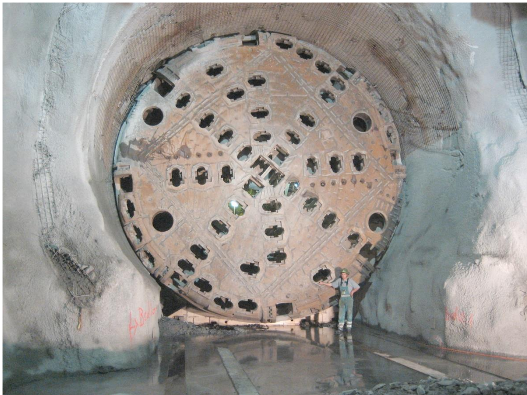
Kuva 5-1 Tunnelipora. (Lähde: Cooper 2006)
