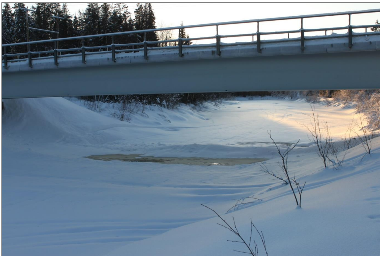
Kuva 5-4. Näkymä Kelujoella Kelukoskentien sillan ali kohti Kitistä. Sillan alla pieni sulapaikka.
